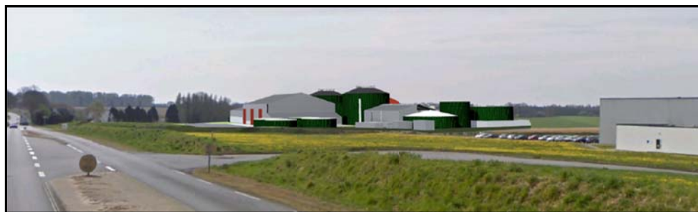
Projet 3D de Biogaz de Bannalec dans son environnement de la ZA Loge Begoarem (29)
