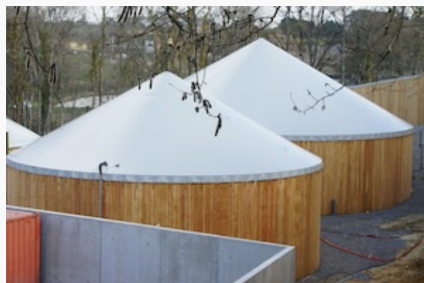
Les cuves, photo Ledjo Energie
